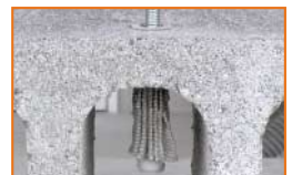
施工例 (プラスチックスリーブ)
